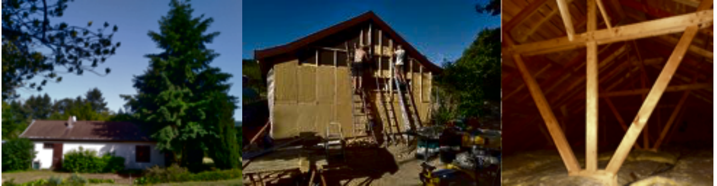
Isolation thermique par l'extérieur réalisée avec les Compagnons Bâisseurs
