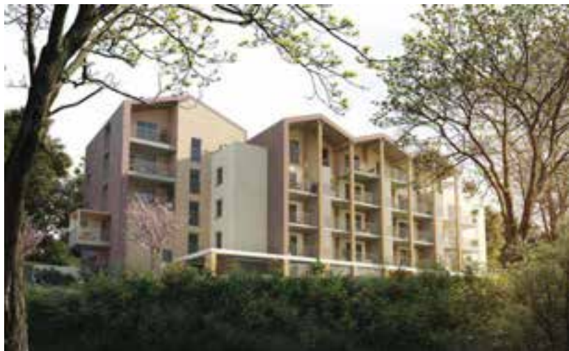
© Rhône Saône Habitat - Vue de la réhabilitation du bâtiment A et ses extensions
