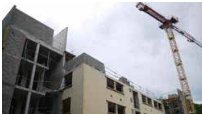
Bâtiment B : existant conservé + extension en blocs béton aggloméré (à gauche sur la photo)
