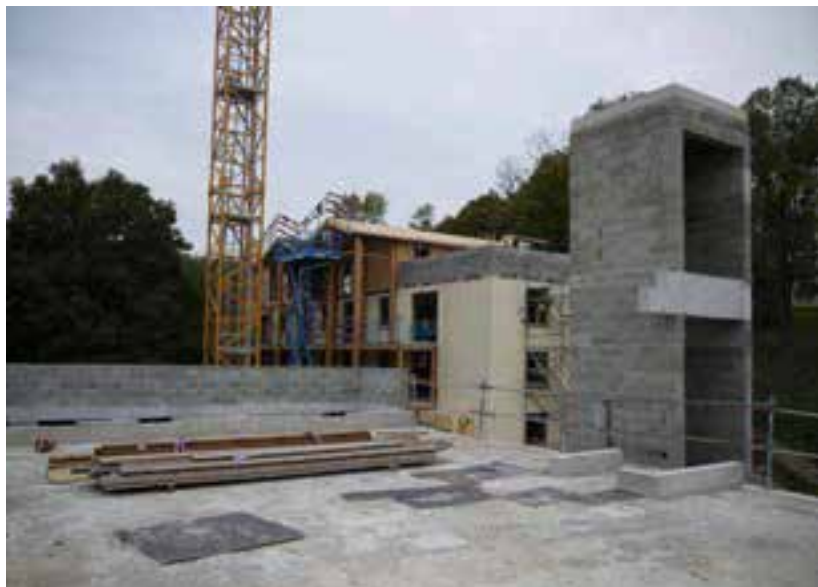
Vue du bâtiment A, prise depuis la toiture du bâtiment B
