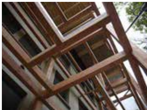
Structure porteuse de la surélévation du bâtiment A, façade nord-est (coursives)
