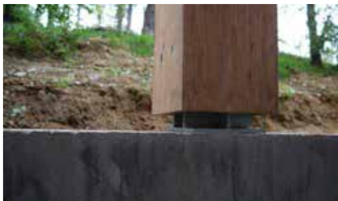
Assemblage métallique Poteau bois – Muret béton
