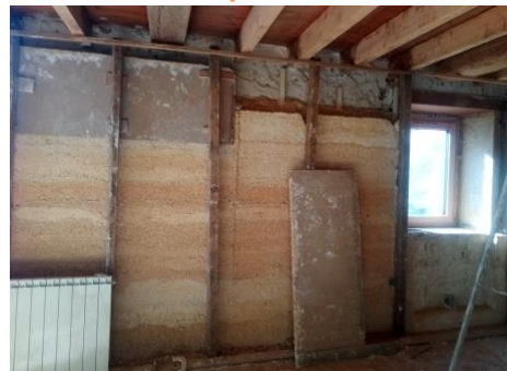
mise en œuvre de l'enduit à correction thermique
