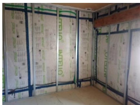
mise en œuvre du frein-vapeur
