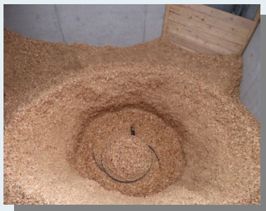
Silo de stockage, vue intérieur
