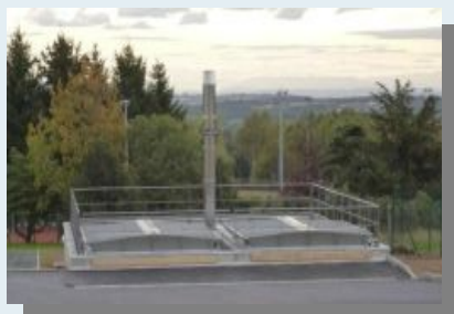
Silo de stockage, vue extérieur
