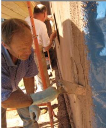
Les murs sont constitués de bottes de paille qui reposent sur un soubassement fait de béton et d'une couche hydrophobe. Les bottes de 36 cm de large offrent une bonne résistance thermique, estimée à R= 5.5. Par ailleurs sa masse volumique (environ 100kg/m<sup>3</sup>) lui permet d'apporter une inertie appréciable.
